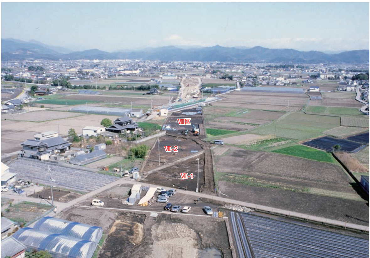
Ⅶ区空撮・西より
