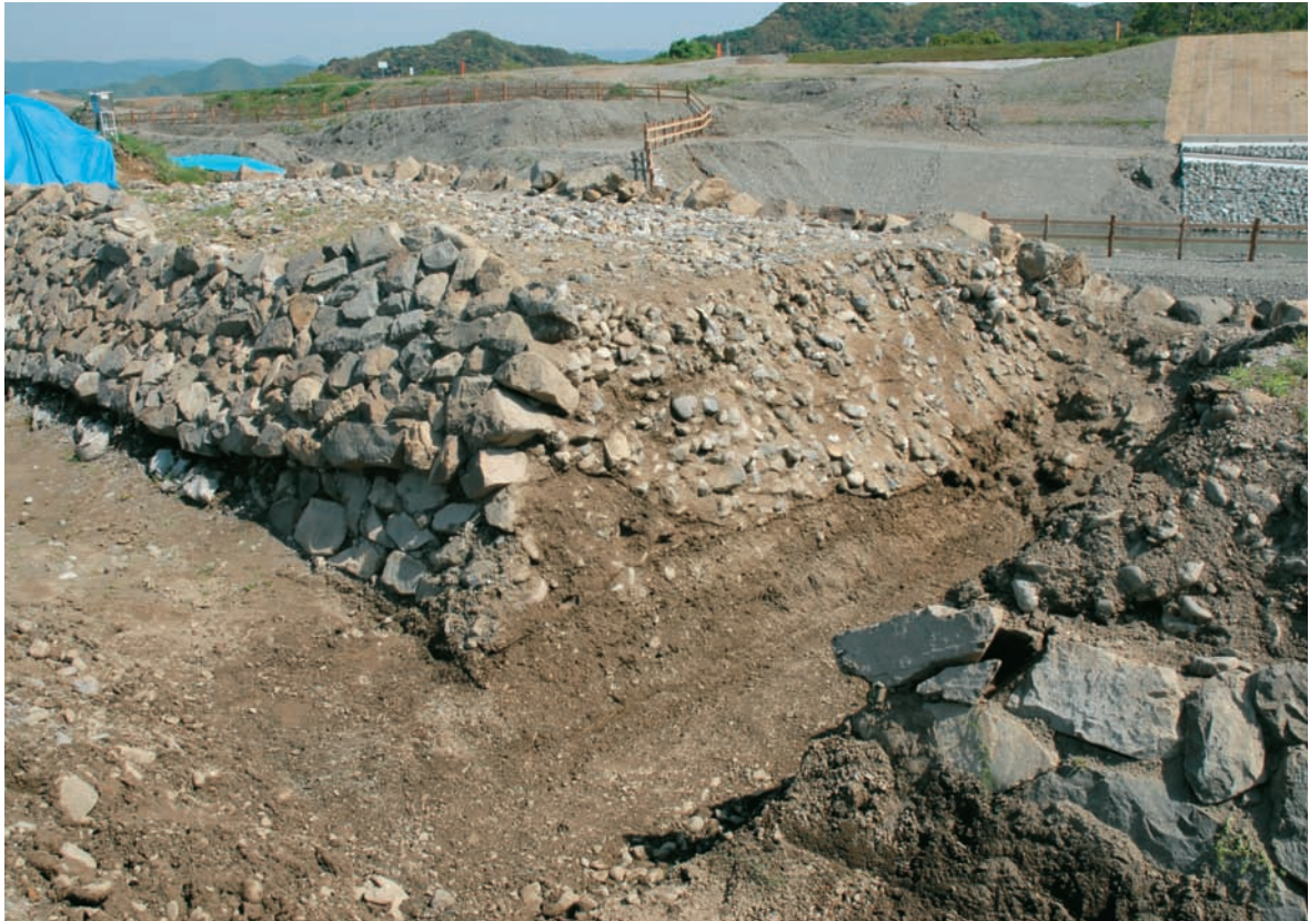
24区 石積み堤防1・2S断面(川裏・川下側から)
