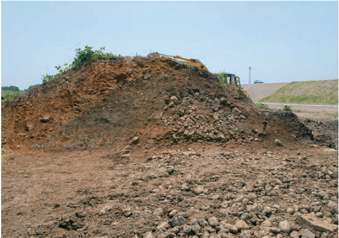
2-4区 旧堤防及び石積堤防断面（川上側から）
