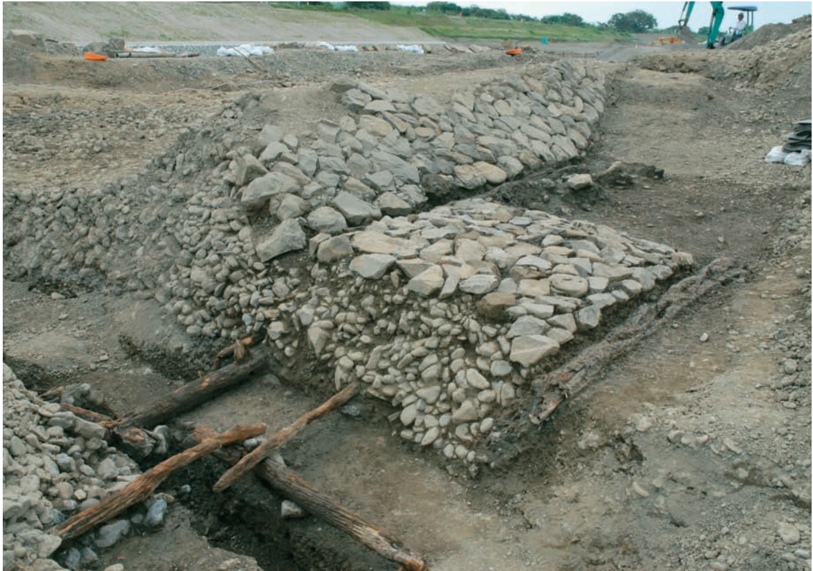
2-3区 石積堤防2N 川裏側基礎 下流端(川上側から)
