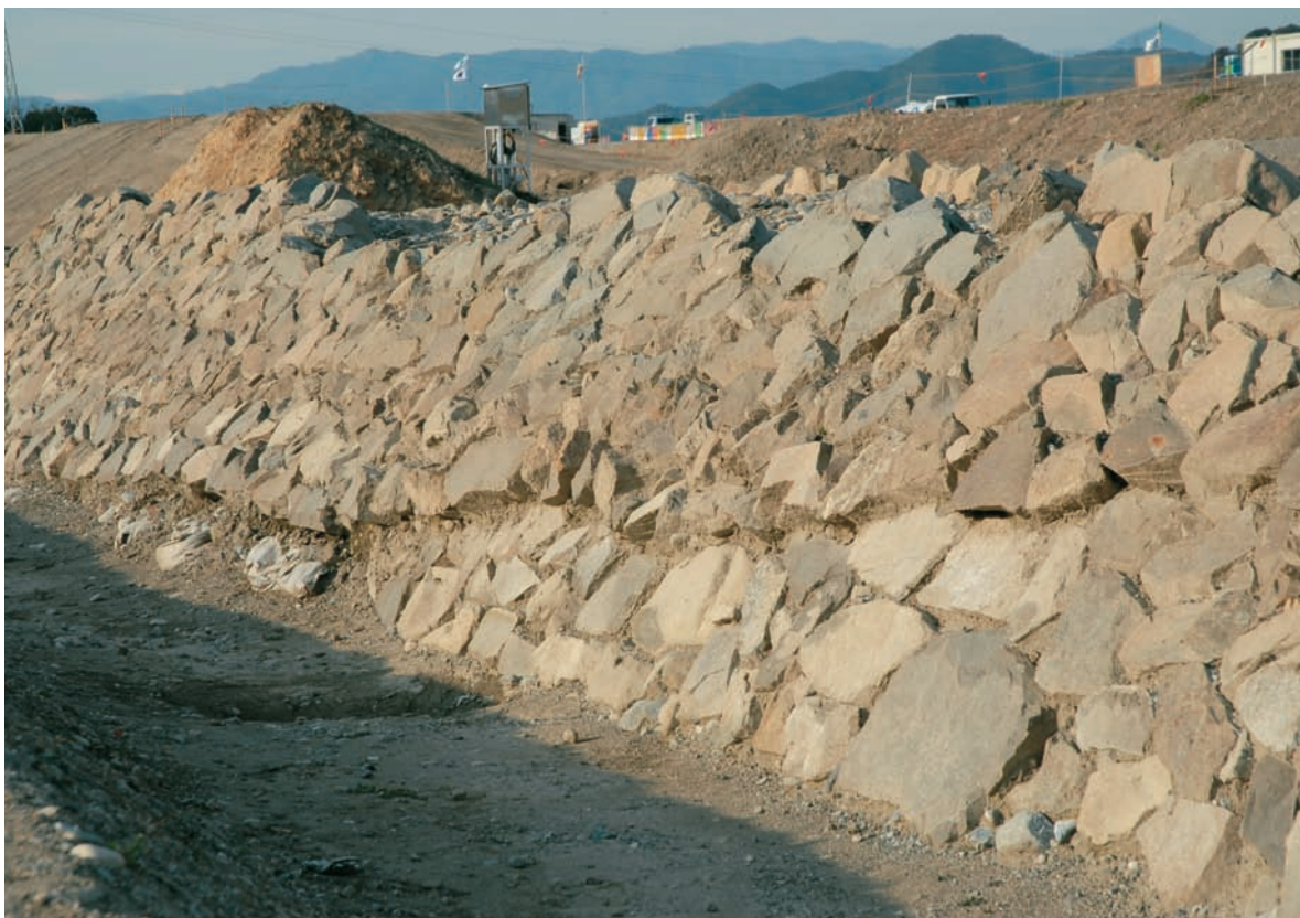
2-4区 石積堤防1・2重複部 川裏側(川下側から)
