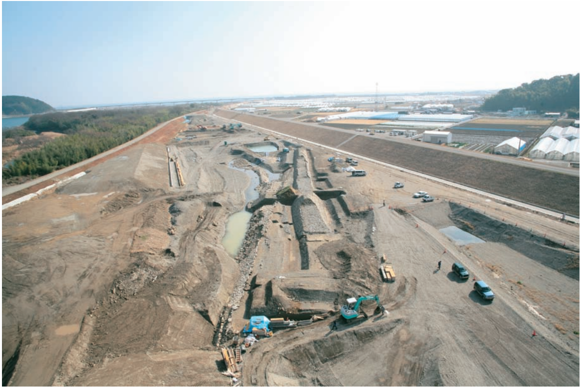
調査第2地点全景（川上側から）
