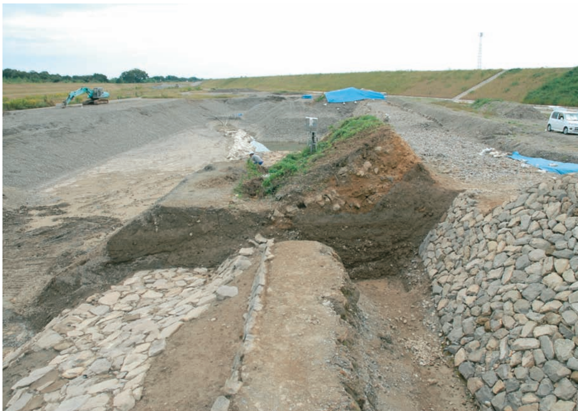
2-3区 旧堤防断面(川上側から)
