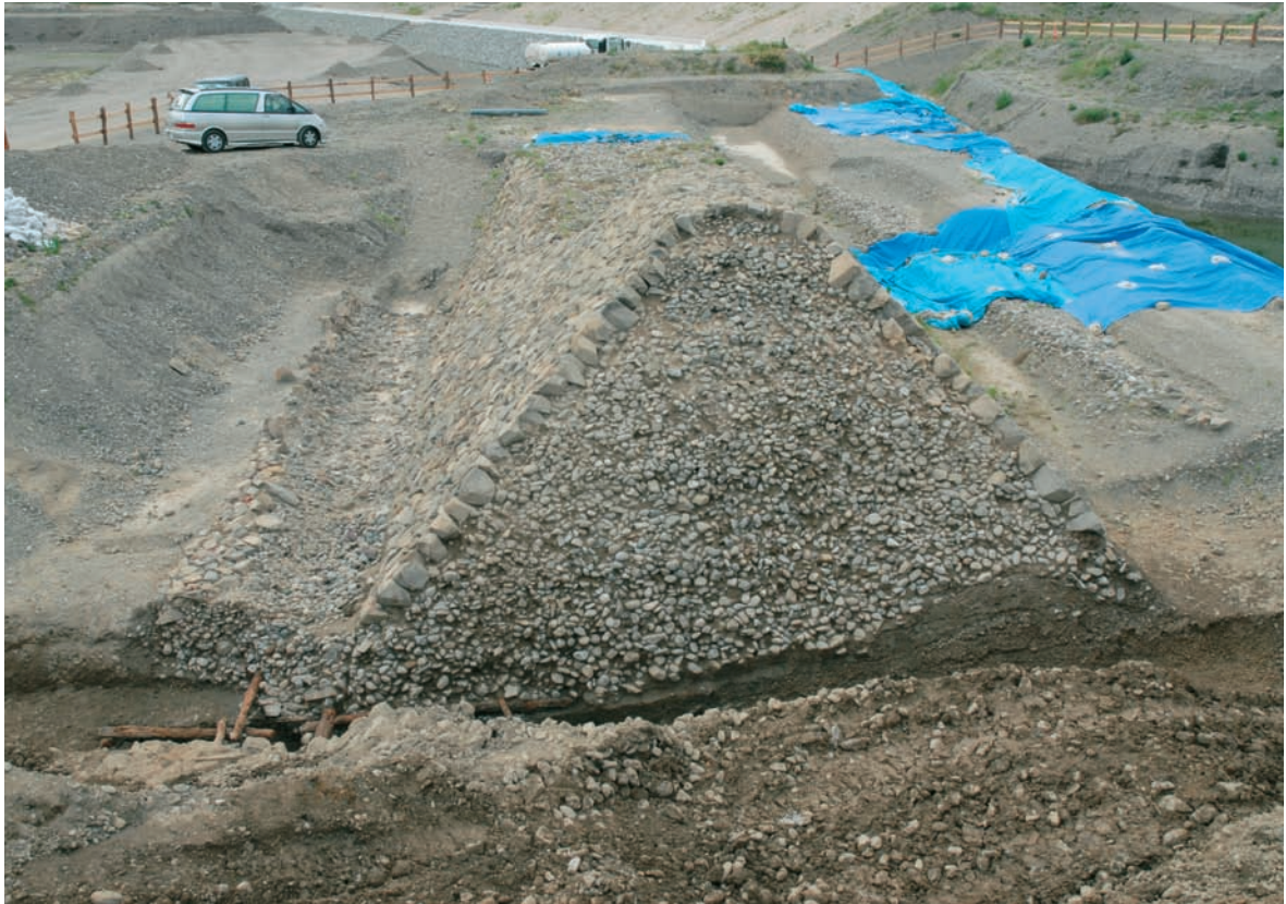
2-3区 石積堤防2N 断面(川下側から)
