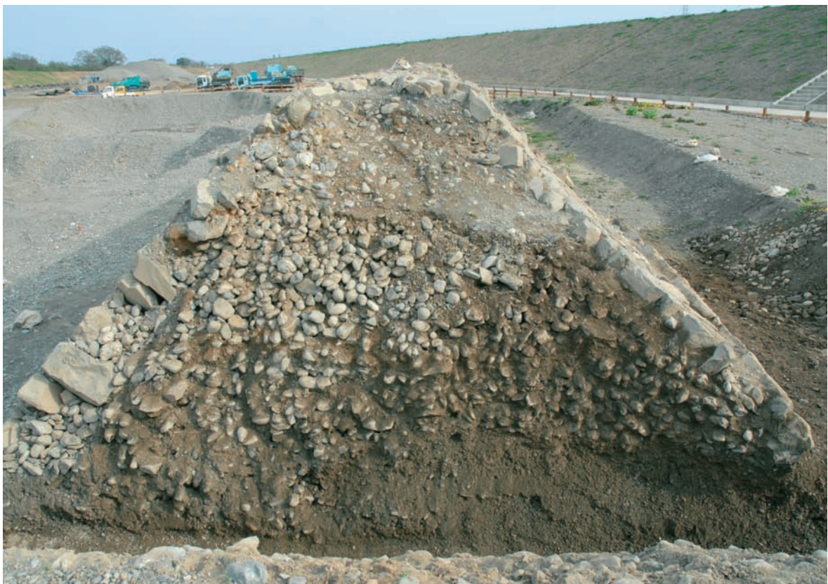
24区南 石積み堤防 南部断面(川上側から)
