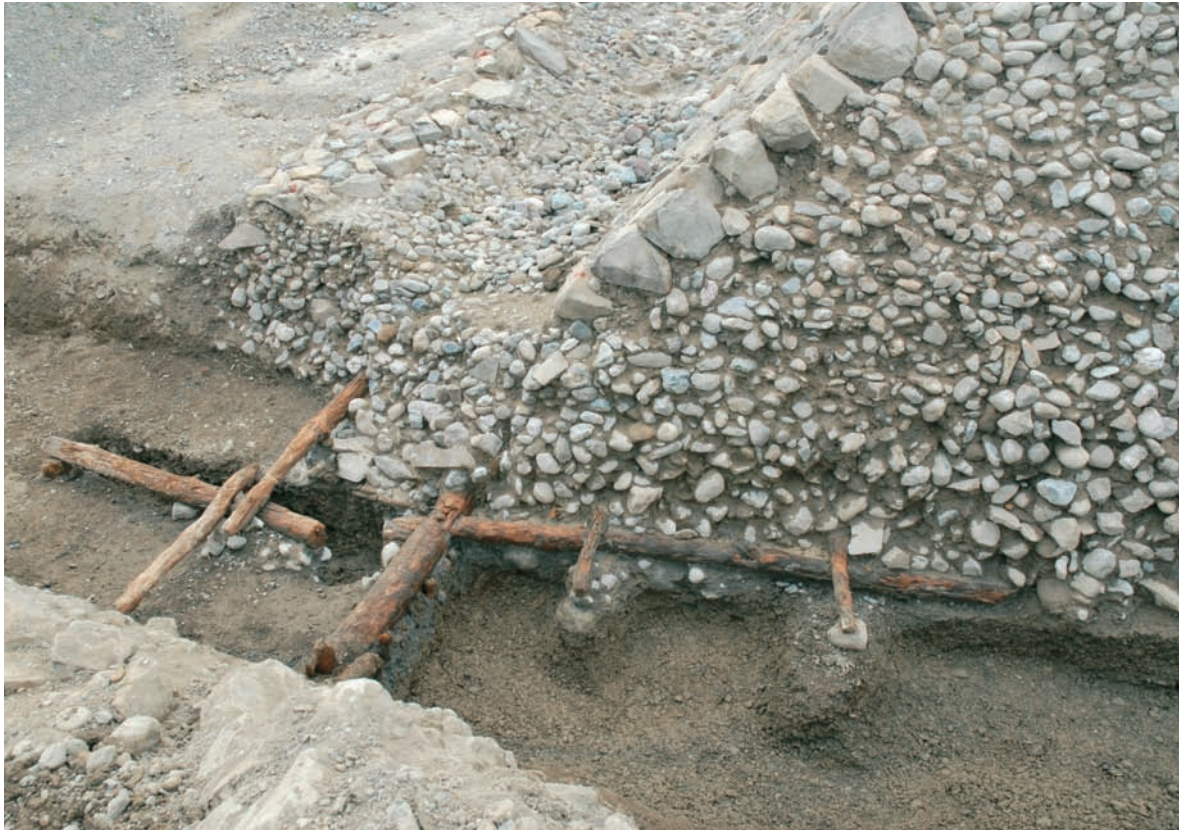
2-3区 石積堤防2N 基礎川裏側(川下側から)
