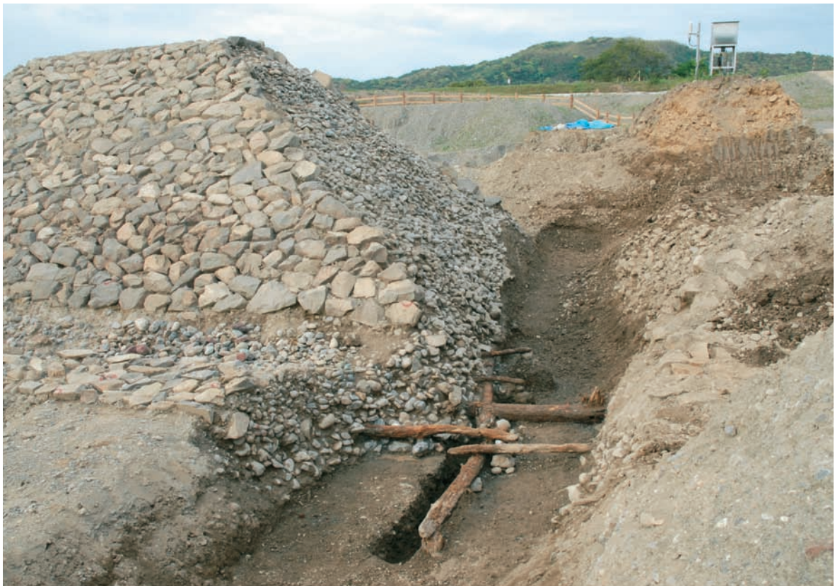
2-3区 石積堤防2N 断面(川裏側から)
