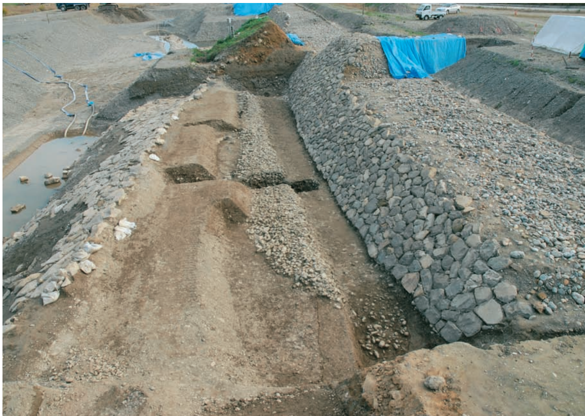
石積堤防2N 川表側基礎検出状況(川上側から)
