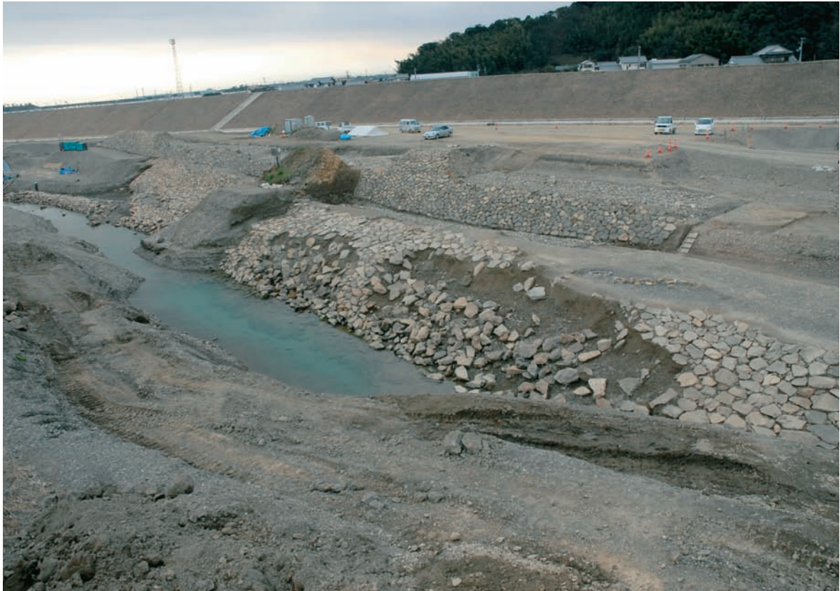
2-5区石積崩落部（川上側から）
