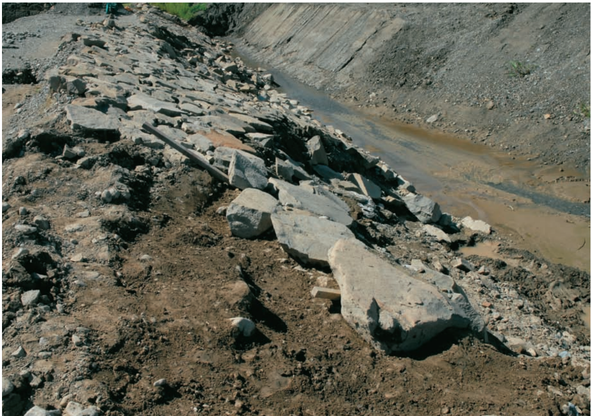
2-5区平場上手 築石除去状況（川下側から）
