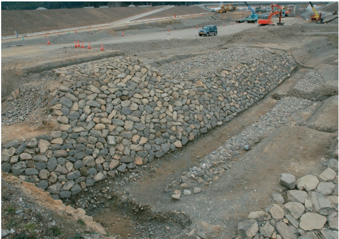
2-3区 石積堤防2N 川表側（川下側から）
