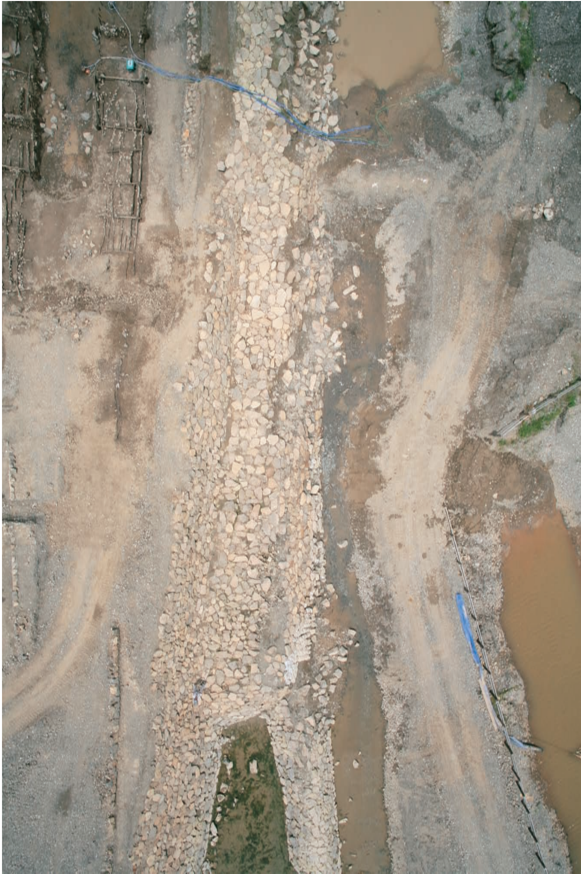
平場部分 直上川下から(左に石積堤防基礎及び石積堤防1)
