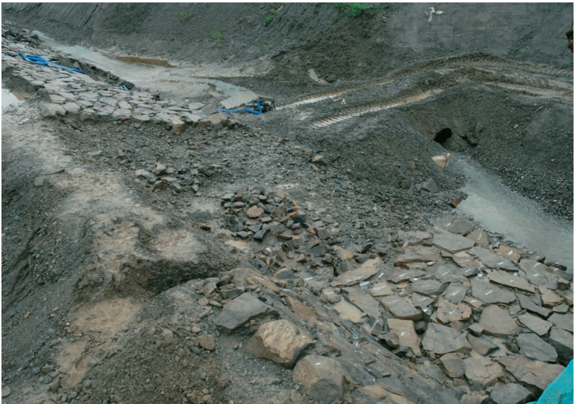
平場 築石取り外し状況(川下側から)
