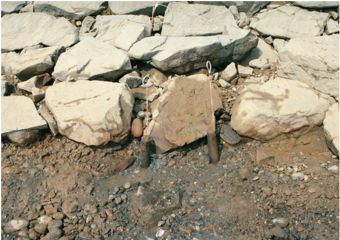
船着状部分護岸裾 配石及び杭(川表側から)
