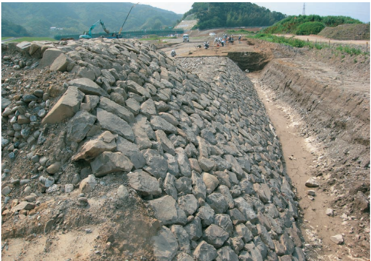
2-3区 石積堤防2N 川表側（川下側から）
