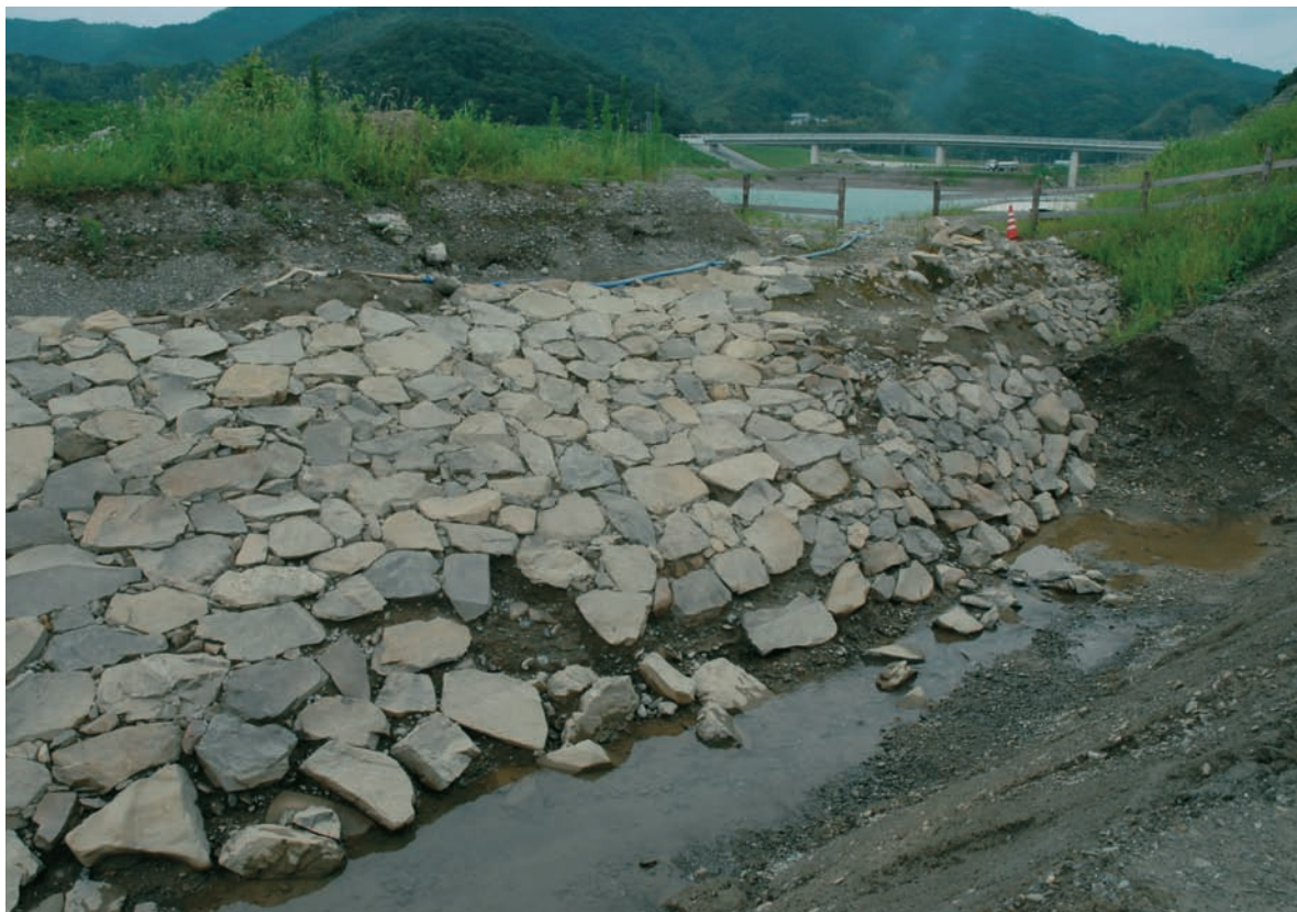
2-5区北端 変化点B付近(川下側から)
