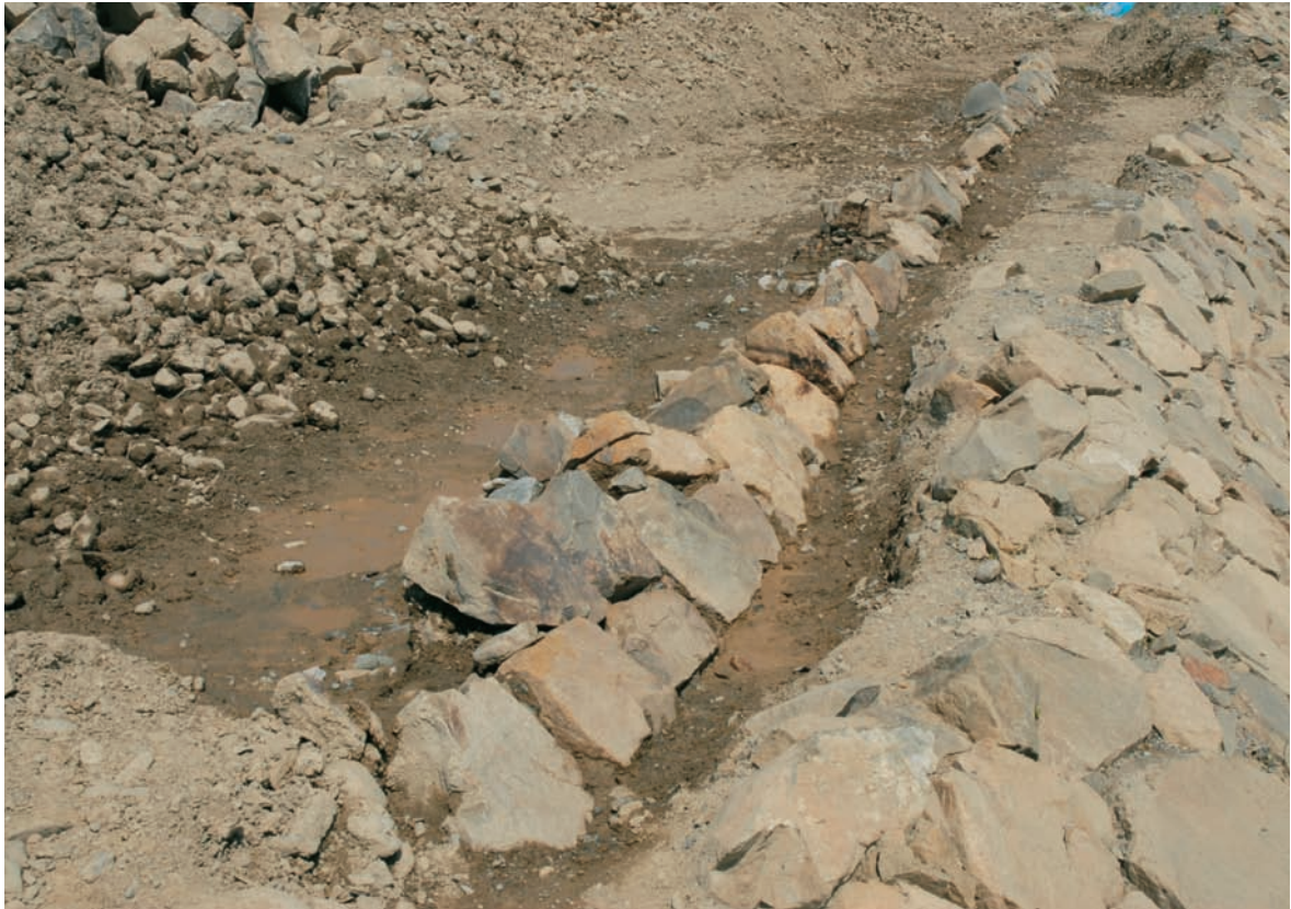
2-4区 石積堤防1 (川表側. 右手は護岸遺構1天端)
