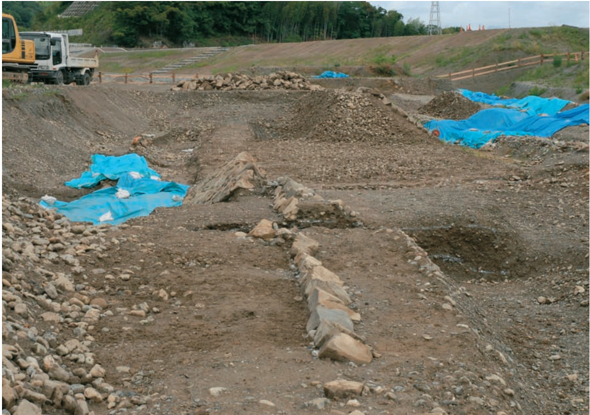
2-3区 石積堤防1N 川裏側(川下側から)
