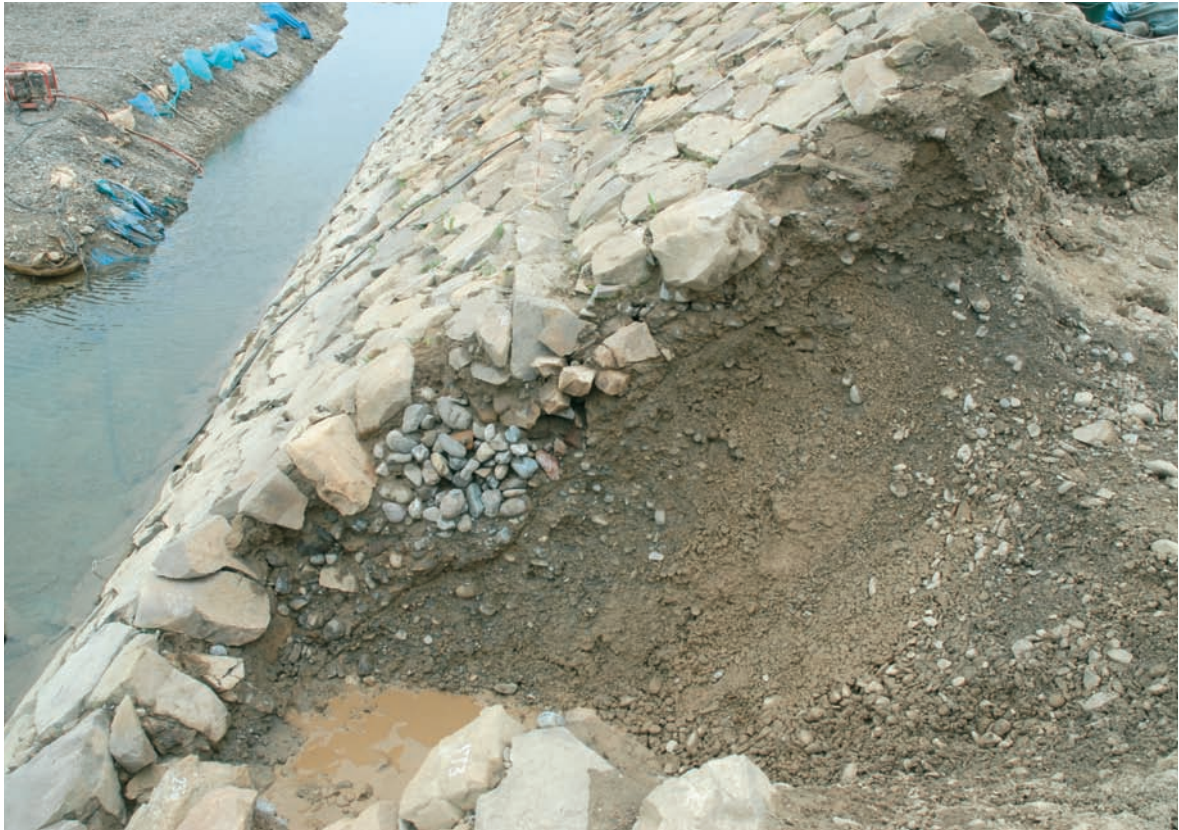
護岸遺構1 断面 平場下手(川上側から)
