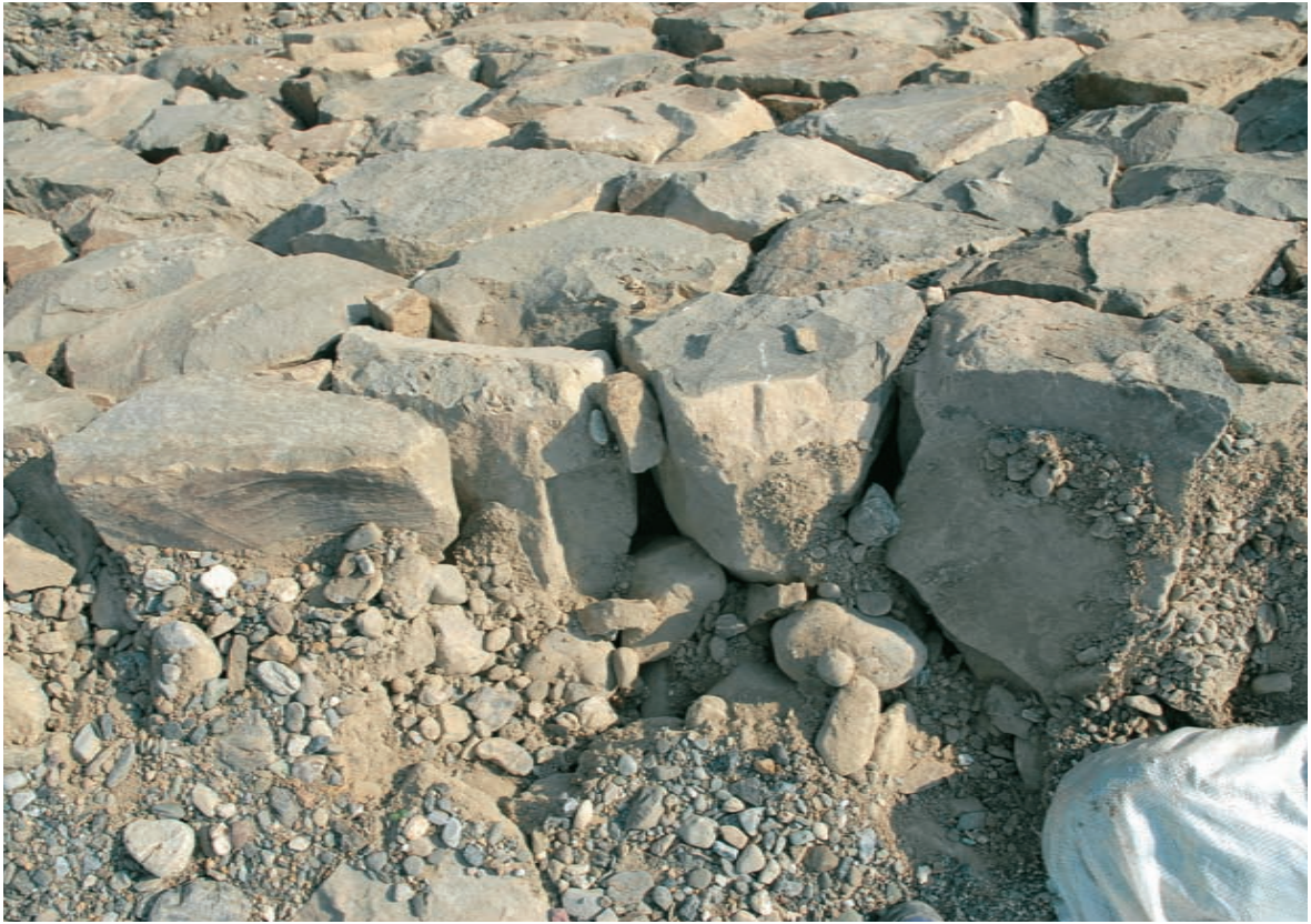
TP10 護岸遺構天端(川裏側から)
