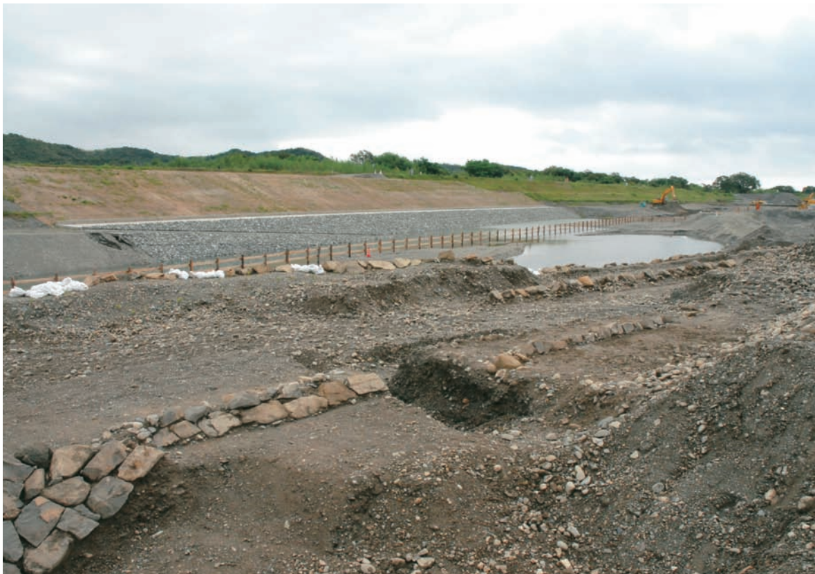
2-3区 石積堤防1N 川裏側(川上側から)
