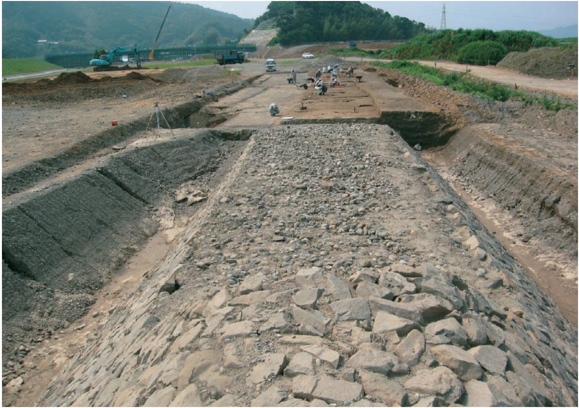
2-3区 石積堤防2Nから中世遺構面（川下側から）
