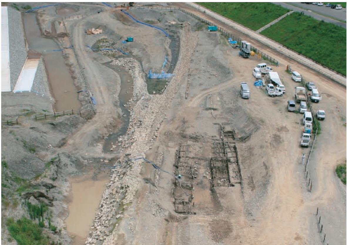
石積堤防最下面及び護岸遺構1(川上側から)
