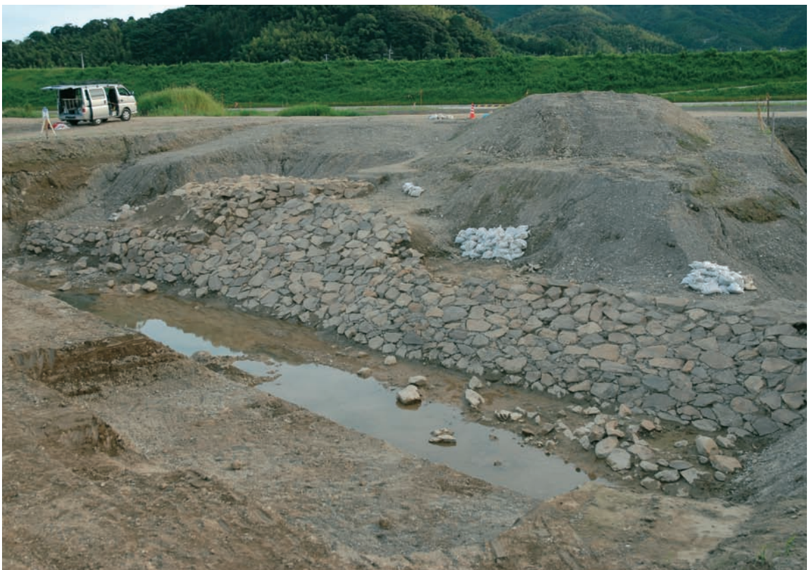
TP9・10 (川表側から)
