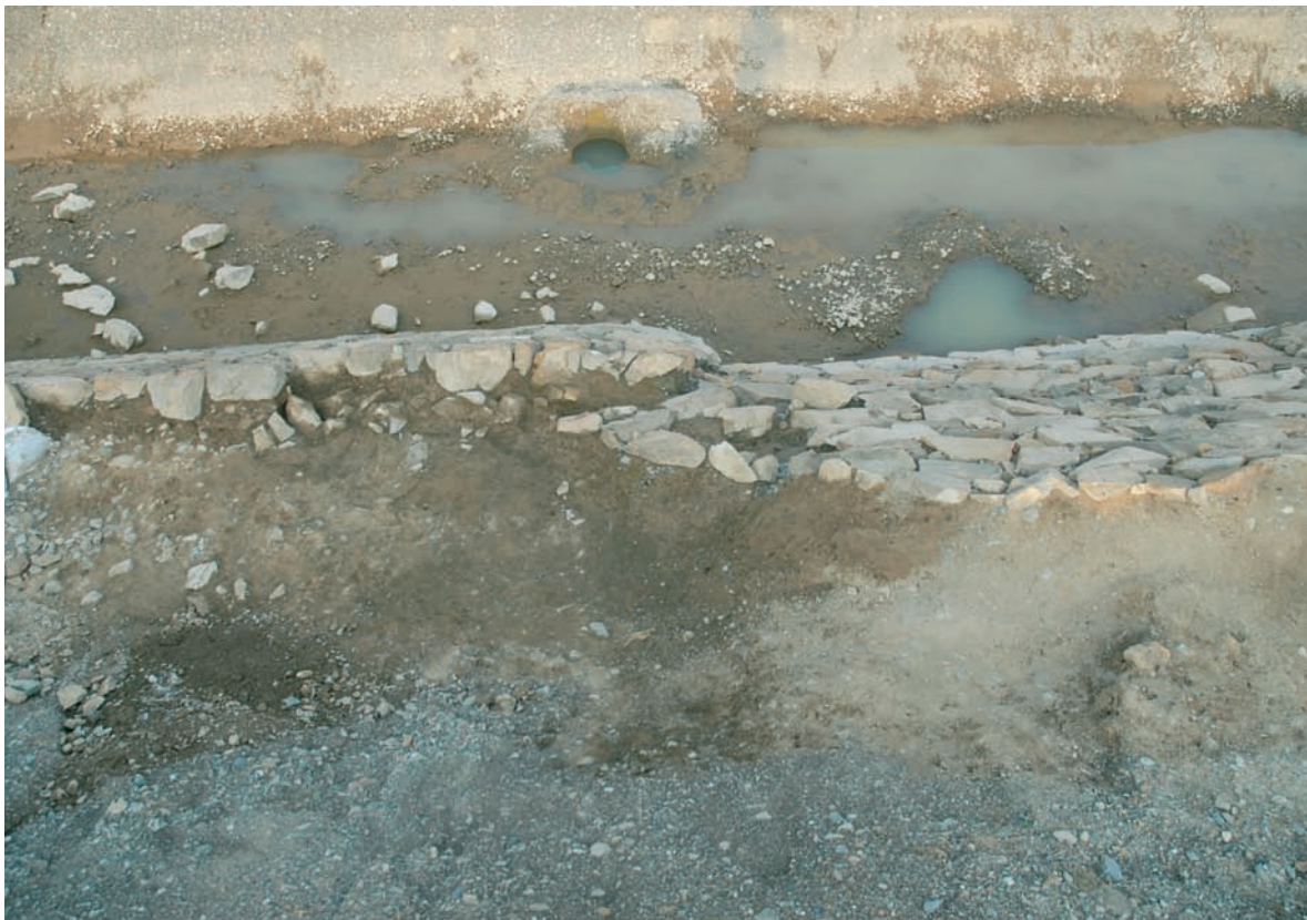
TP10 護岸遺構1 変化点A (川裏側から)
