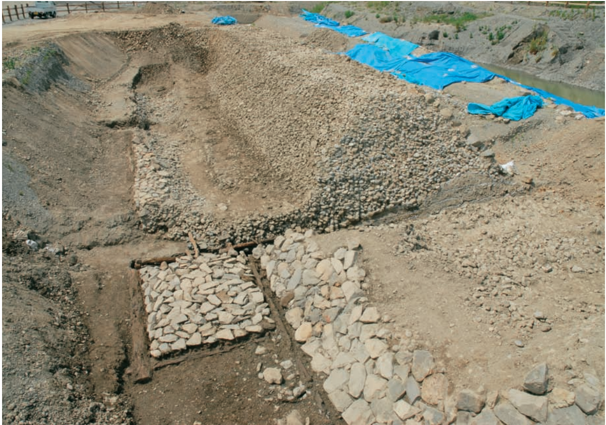
石積堤防 川上部分上部縦・横断面(2-3区 川裏から)
