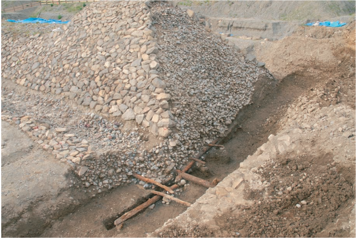
石積堤防断面 川裏側から
