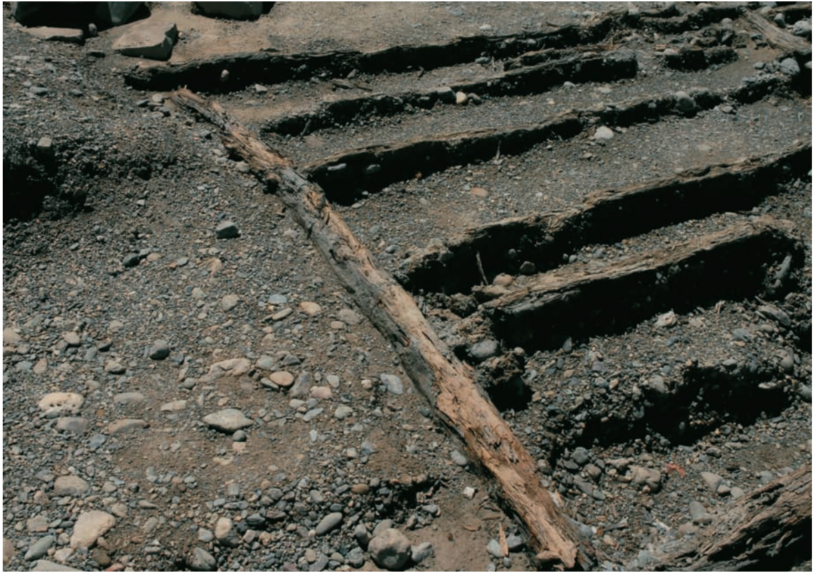
川表側南端土台D-E15 (川表側から)
