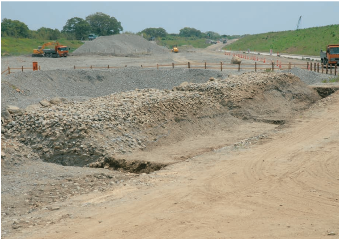
2-4区 石積堤防縦断面 (川裏側・川上側から)
