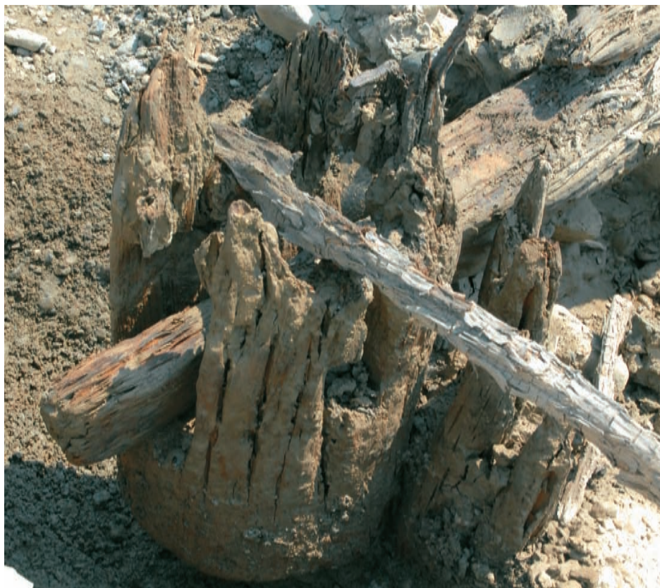
川表側E6柱（川上側から）
