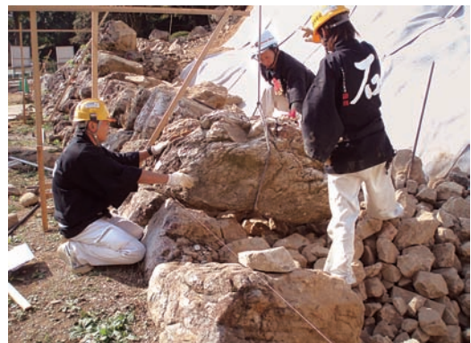
写真29 当りや勾配を見ながら築石を設置する
