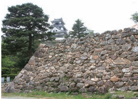
写真18 三ノ丸東面石垣
