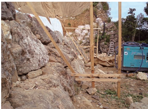
写真28 丁張りとは配の様子
