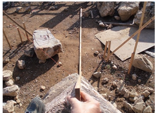
写真27 出角部分の引き抜きの丁張り
