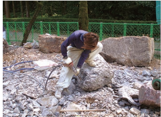
写真23 削岩機による石加工
