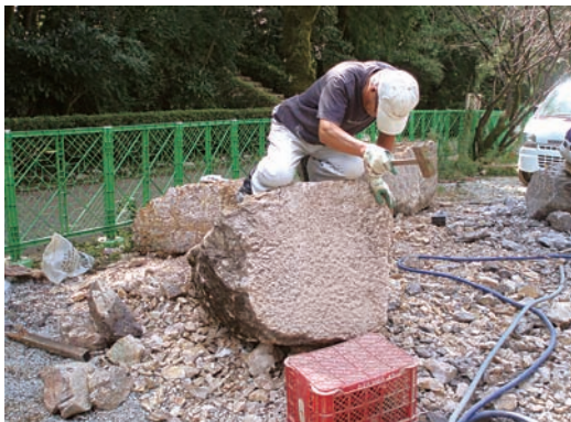
写真26 角石ビシャン仕上げの様子
