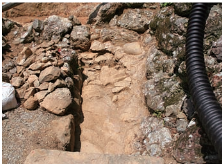
写真20 入角部排水溝(三ノ丸東面)
