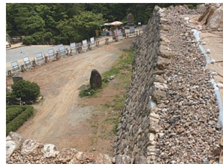
写真19 三ノ丸東面裏込め状況
