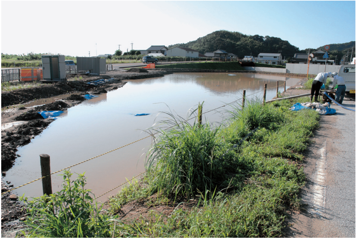
冠水状況（北から）
