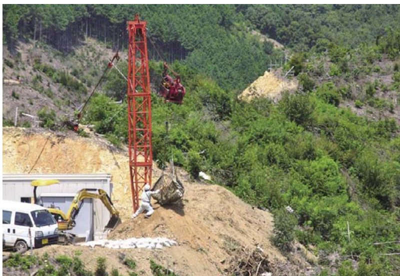
スカイキャリーによる土砂の運搬作業
