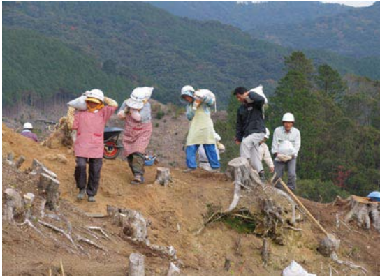
12.13(月) コンクリートシューターを設置し、B区北からD(北斜面)西側へ排土搬出を始める。
