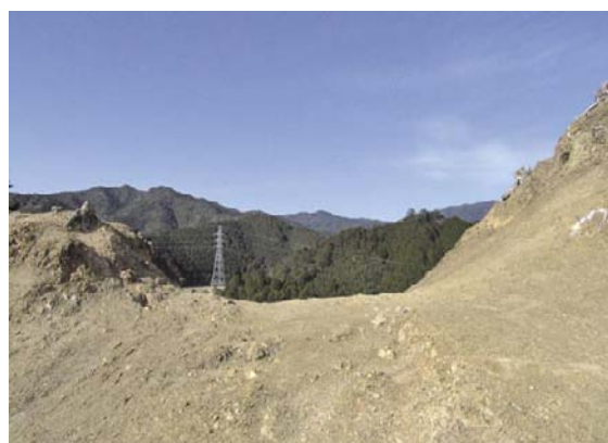
C区掘切8完掘状況（東より）
