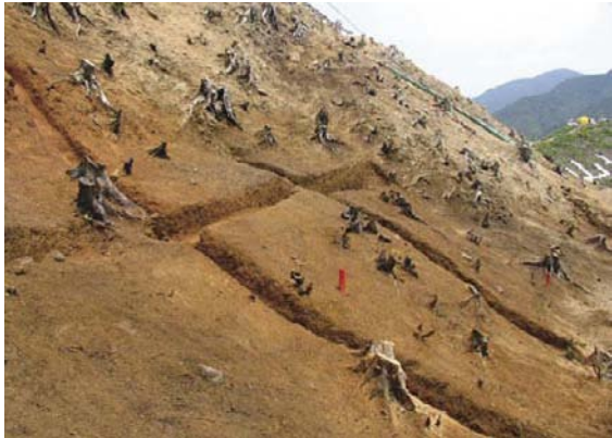
E区 TR1~3設定状況 (南より)
