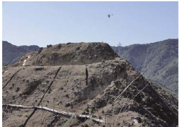
ラジコンヘリによる航空写真測量 2005. 3. 8
