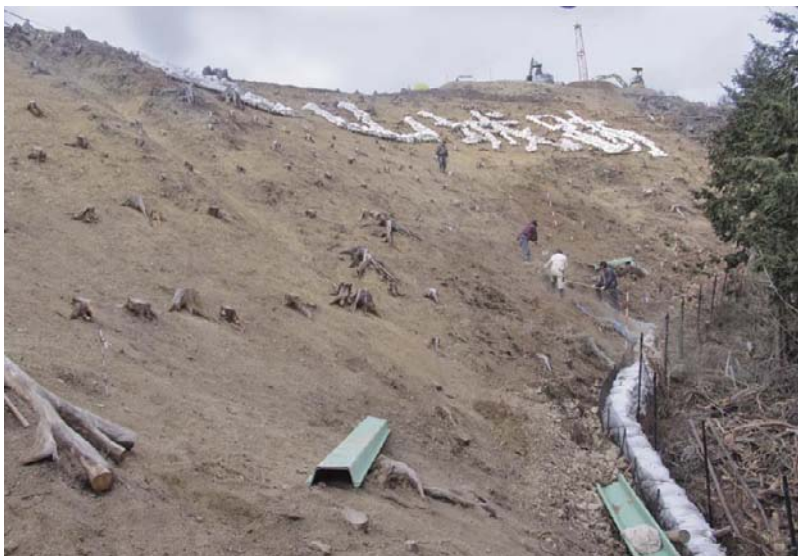
D区東斜面作業風景（南より）
